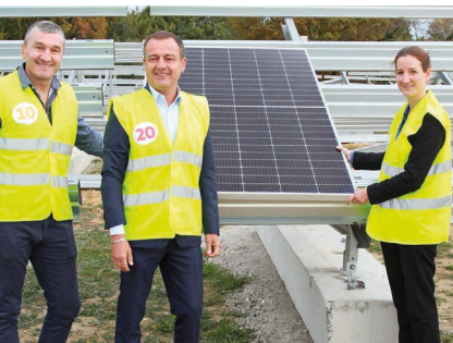
Pose du premier panneau de la centrale photovoltaïque au centre de tri de la SMTD65, le 27 octobre 2022
