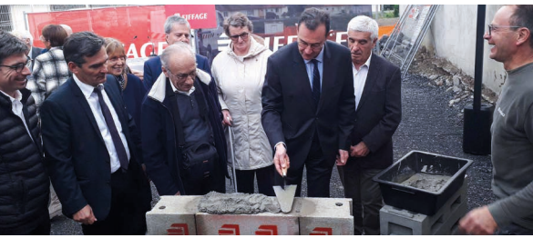
Pose de la première pierre dans le cadre du projet NPNRU de l'Ophite, le 7 novembre 2022
