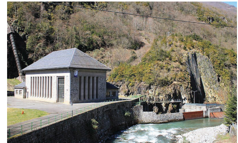
Centrale hydroélectrique du Pont de la Reine
